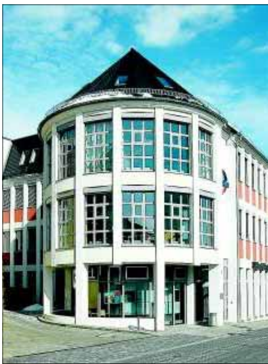
Das Verwaltungs- und Kundenzentrum der Stadtwerke Merseburg in der Großen Ritterstraße 9. Foto: Carsten Heinke
