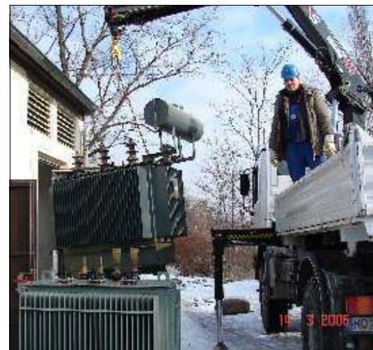
Von Anwohnern und Kunden so gut wie unbemerkt ging der Wechsel der Transformatoren vonstatten.
