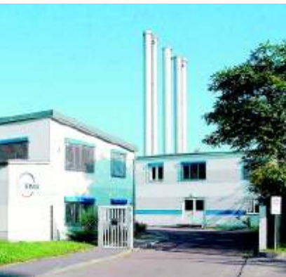
Der Stadtwerke-Standort in Merseburg West. Hier befinden sich das Blockheizkraftwerk und die zentrale Leitwarte.
