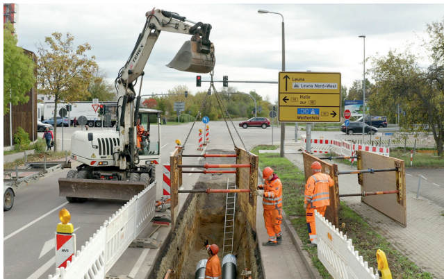
Im Rahmen unseres Fernwärmenetzesausbaus wurden auch in der Geiseltalstraße Rohrleitungen verlegt.
