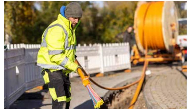
David Eckardt von der Firma Heuchling bei der Verlegung eines Micropipe-Verbundes im Erlenweg
