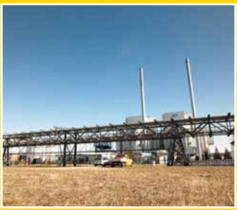
Verlegung DN 250 St Rohrbrücke INFRA 600 m Trasse und Bau der Fernwärme-Übergabestation.
