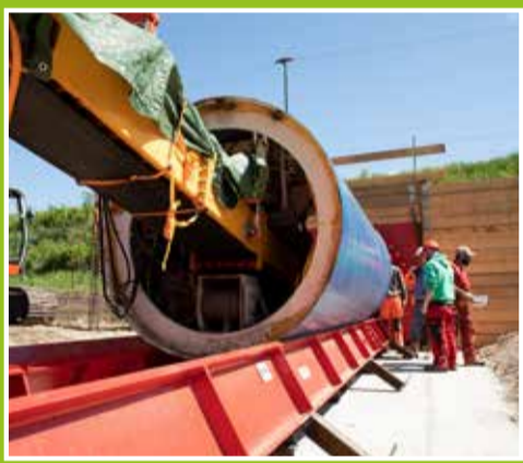
Durchörterung eines Bahndammes der DB AG mit einem Stahlbetonschutzrohr DN 1400.
