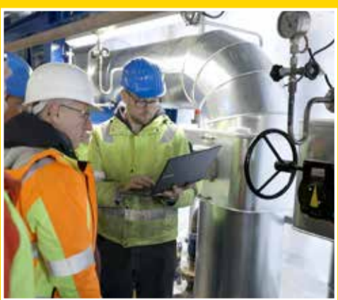
Fernwärme-Übergabestation, Testlauf der Pumpen.
