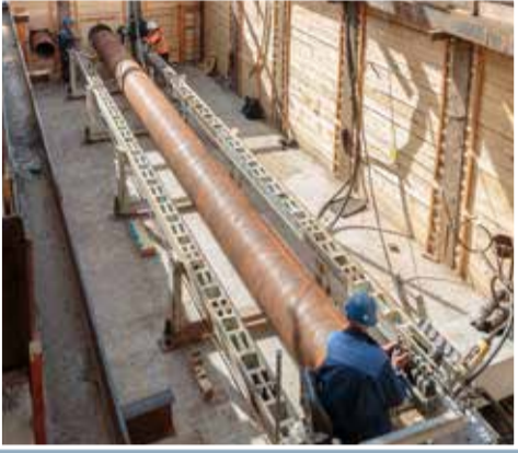
Durchörterung der B91 in geschlossener Bauweise.
