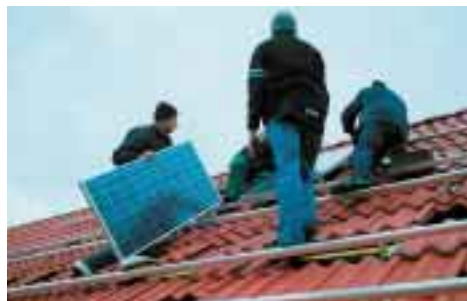
Die Montage der Module: Alle zusammen haben eine Leistung von 62 Kilowatt
