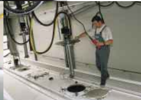
Einsetzen der Spüldüsen in die Silofahrzeuge
