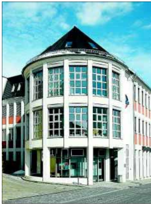
Das Verwaltungs- und Kundenzentrum der Stadtwerke Merseburg in der Großen Ritterstraße 9. Foto: Carsten Heinke
