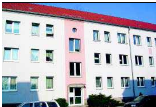
Von den insgesamt 26 Gebäuden der Merseburger Immobilien Verwaltungsgesellschaft mbH (MIG), die in Merseburg auf ihre Energieeffizienz geprüft wurden, erhielten alle einen Energiepass mit sehr guten Werten. Fotos: E. Krömer
