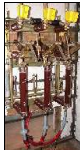
Auch das alte Schaltgerät für den Transformator wurde beim Umbau durch dieses moderne Gerät ersetzt.
