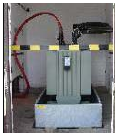
Der neue Hermetic-Trafo garantiert höchste Versorgungssicherheit bei minimaler Wartung. Foto: SWM
