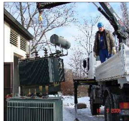
Von Anwohnern und Kunden so gut wie unbemerkt ging der Wechsel der Transformatoren vorstatten.
